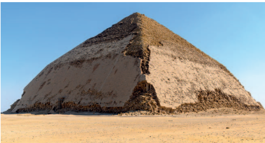
Скосената пирамида на Снофру в Дашур – тук много ясно се вижда как рязко се променя ъгълът на наклона на стените по средата на пирамидата.
